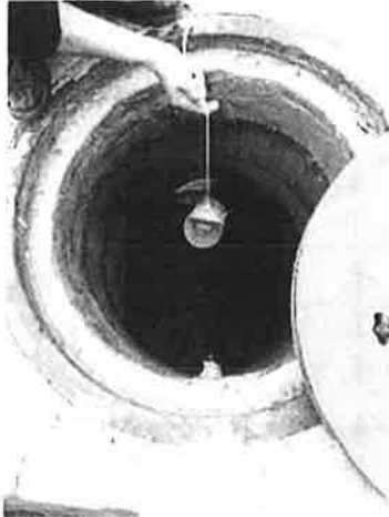
生活污水排放口
