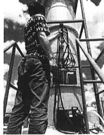
焊接废气处理后排放口
