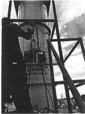
清洗、三防废气处理后排放口
